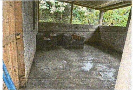
Foto 6: Resultados final de piso de torta para cocina.
