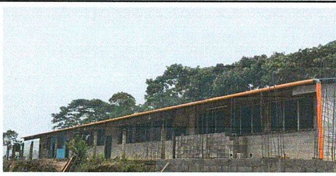
Foto1: INSTALACION FINAL DE TUBO DE PVC PARA CANALES Y BAJADAS DE AGUAS DEL ESTABLECIMIENTOS.
