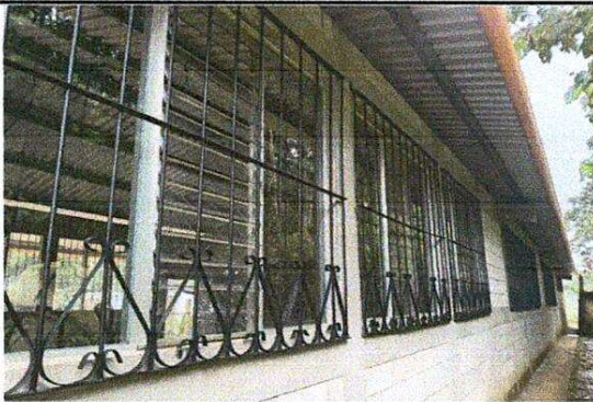
Foto 3: INSTACION FINAL DE BALCONES DE METALES PARA LA SEGURIDAD DEL EDIFICIO ESCOLAR
