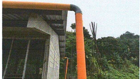
Foto 2: INSTALACION DE CODO PVC PARA BAJADAS DE AGUA
