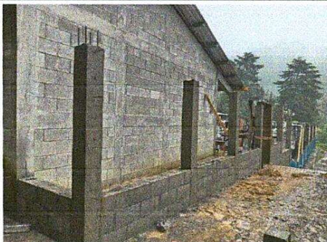
Foto 5 RESULTADOS FINAL DE CIMIENTO Y COLOCACION DE BLOCK PARA MURO PERIMETRAL PARA MALLA.
